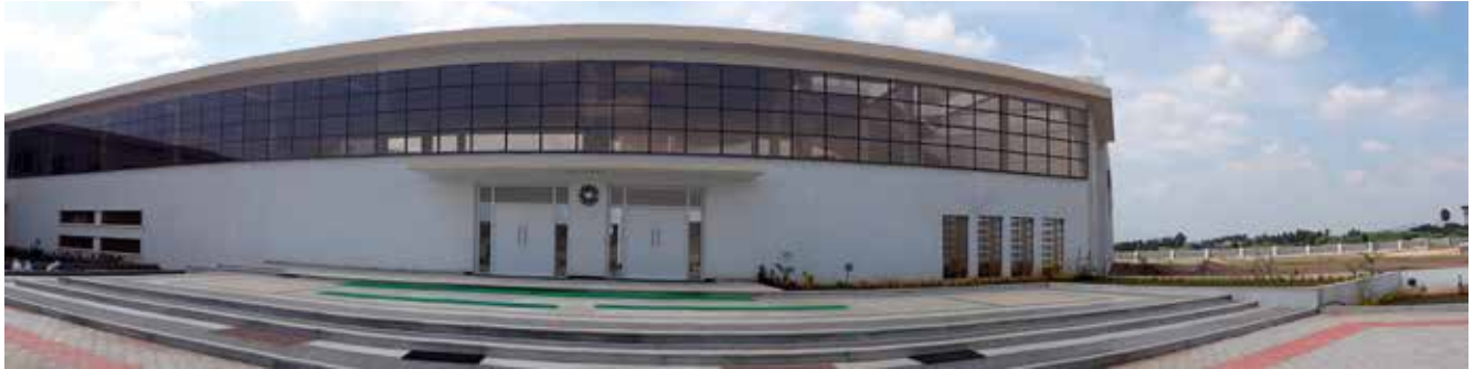
SSM工程与技术研究所
